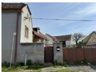
vstup do objektu, oplocení vytvořeno zdivem a plechovými vraty
