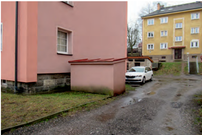
Na pozemku parc.č. 2948 stojí uzavřený přístřešek na odpadové nádoby
