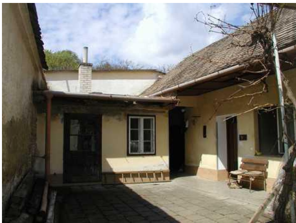
Východní dvorní pohled na hospodářské stavení
