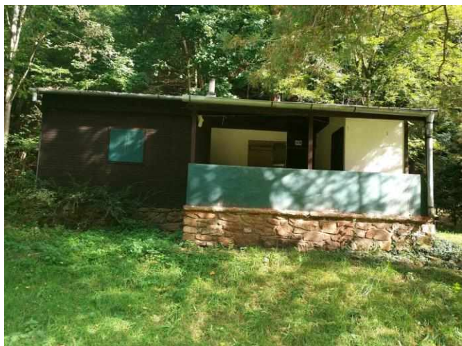
celkový jihozápadní pohled
