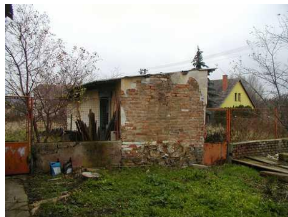
Severozápadní pohled na včelín
