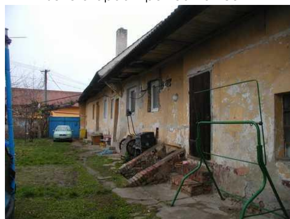
Východní dvorní pohled na č.p. 13
