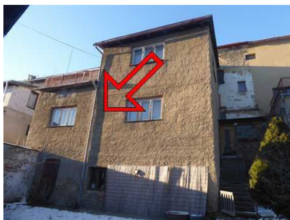
pohled JV - bytová jednotka v1.NP
