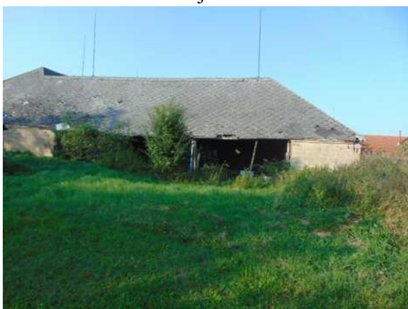
Zadní stěna zem. stavby-kolny
