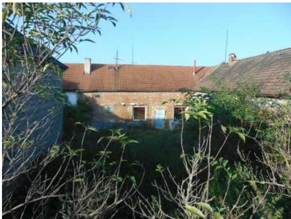
Pravá část dvorní stěny obytné části
