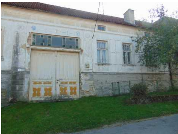
Pohled na vjezdová vrata
