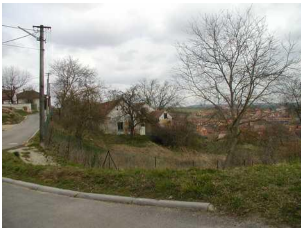
Jižní pohled na č.p. 93
