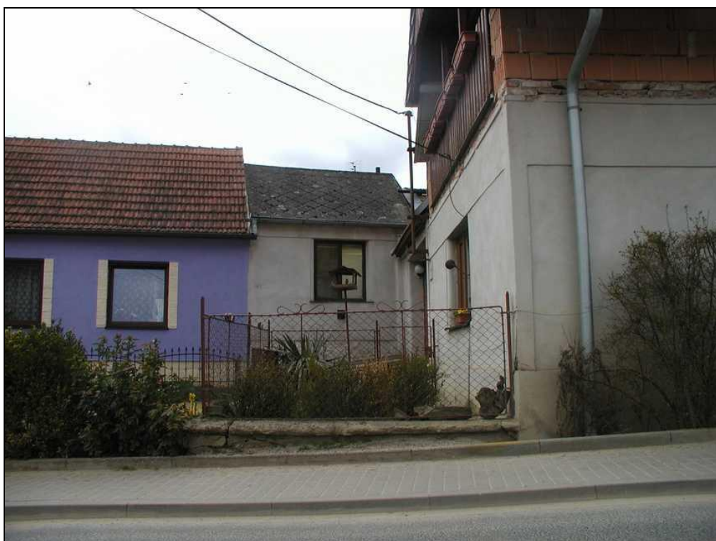
Severní pohled na č.p. 42
