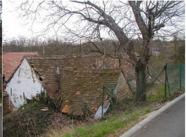
Severní pohled na č.p. 93
