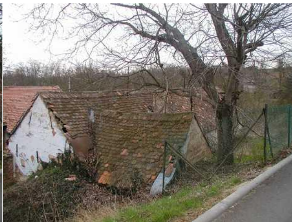
Severní pohled na č.p. 93
