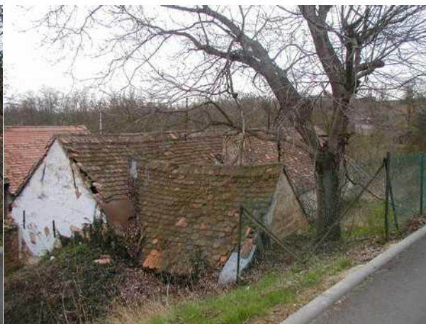
Severní pohled na č.p. 93
