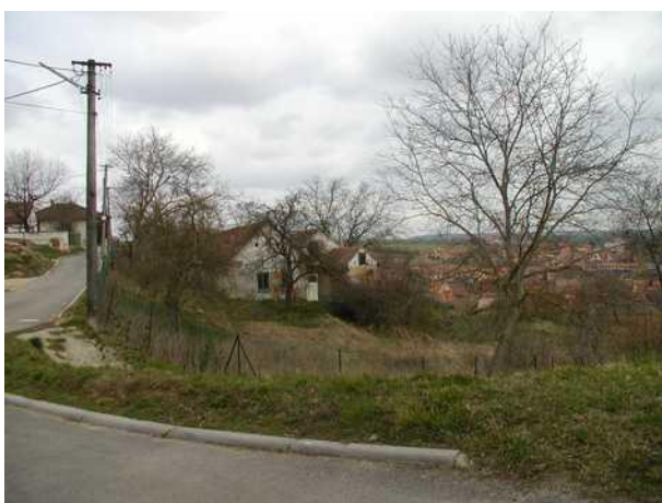
Jižní pohled na č.p. 93
