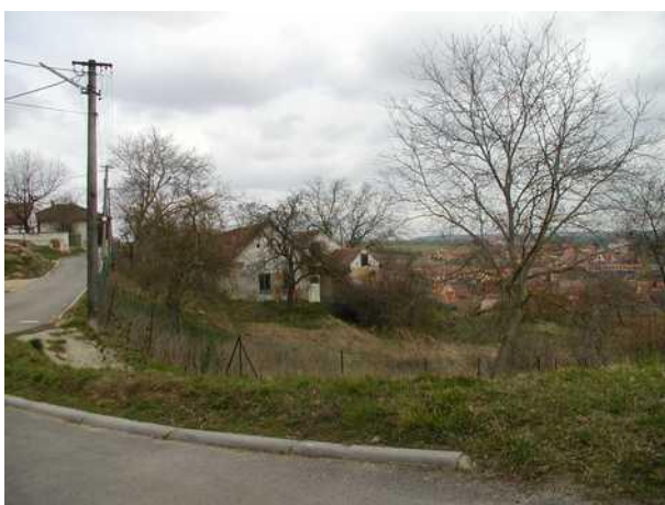
Jižní pohled na č.p. 93
